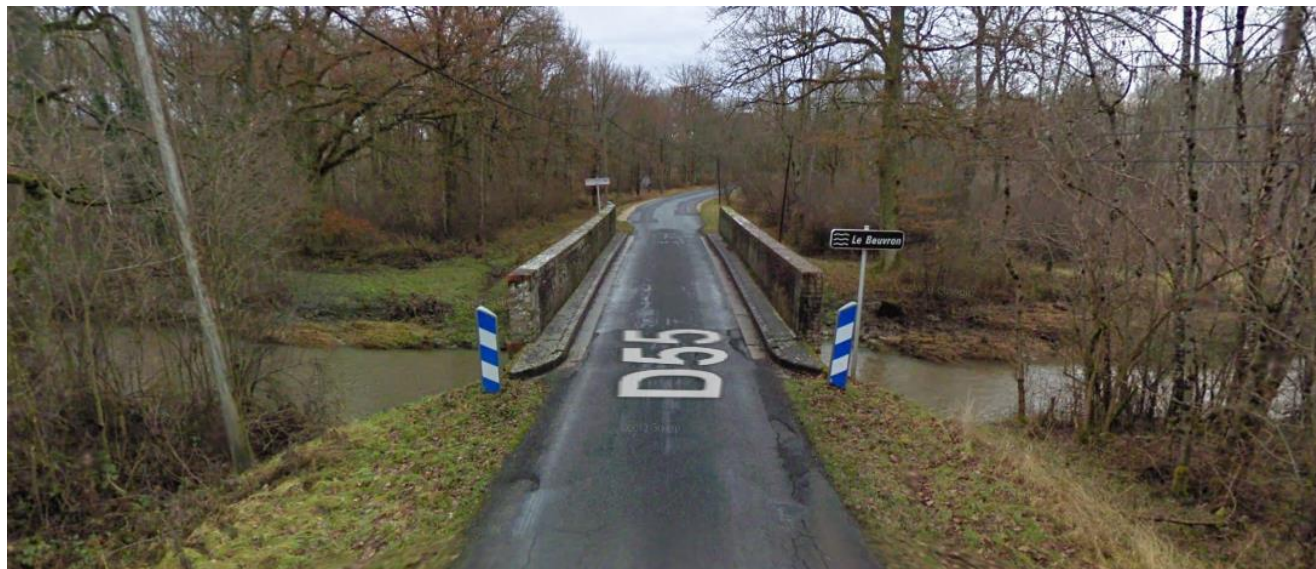
Figure 47 : Vue sur le pont du cours d'eau Le Beuvron (franchissement 4) (source : Google Street View, 2022)
