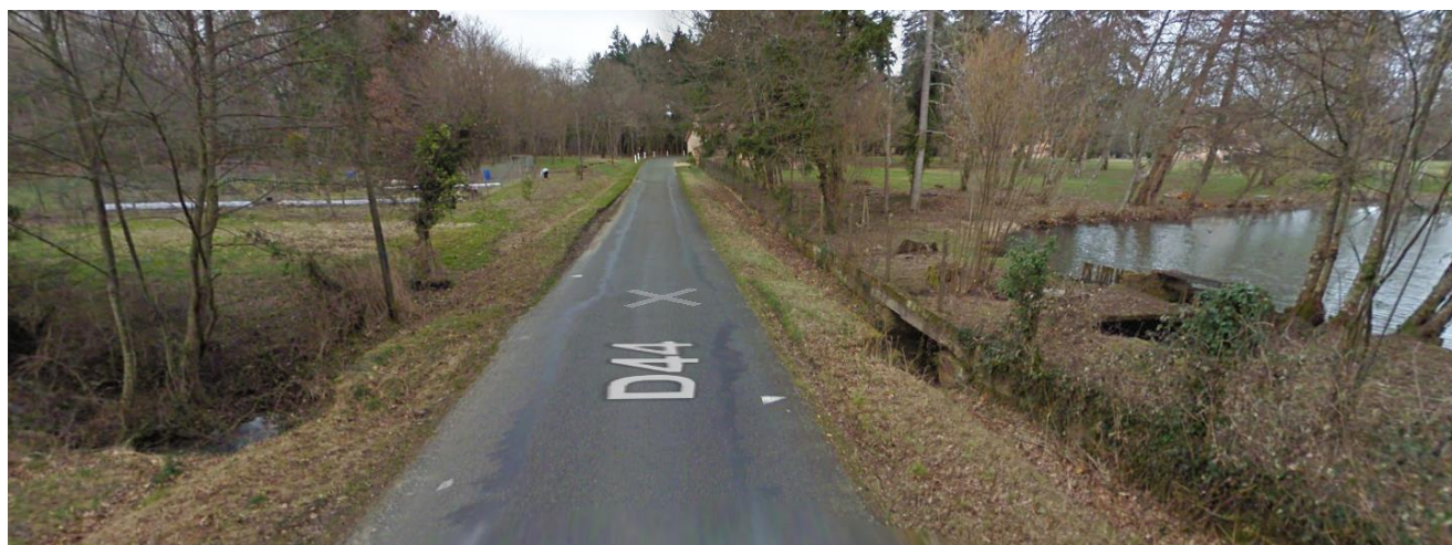
Figure 51 : Vue la buse permettant la traversée du cours d'eau du Bouillon (franchissement 8) (source : Google Street View, 2022)
