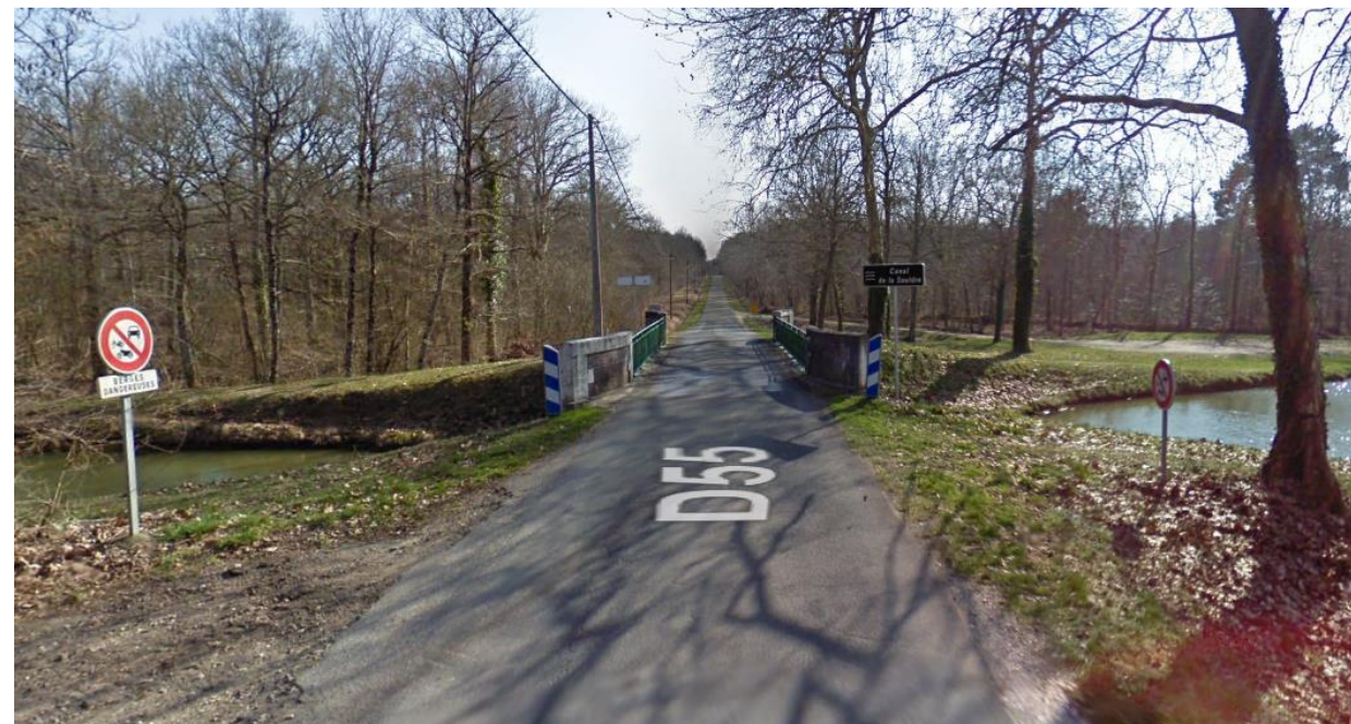
Figure 49 : Vue sur le pont de l'ancien Canal de la Sauldre (franchissement 6) (source : Google Street View, 2022)
