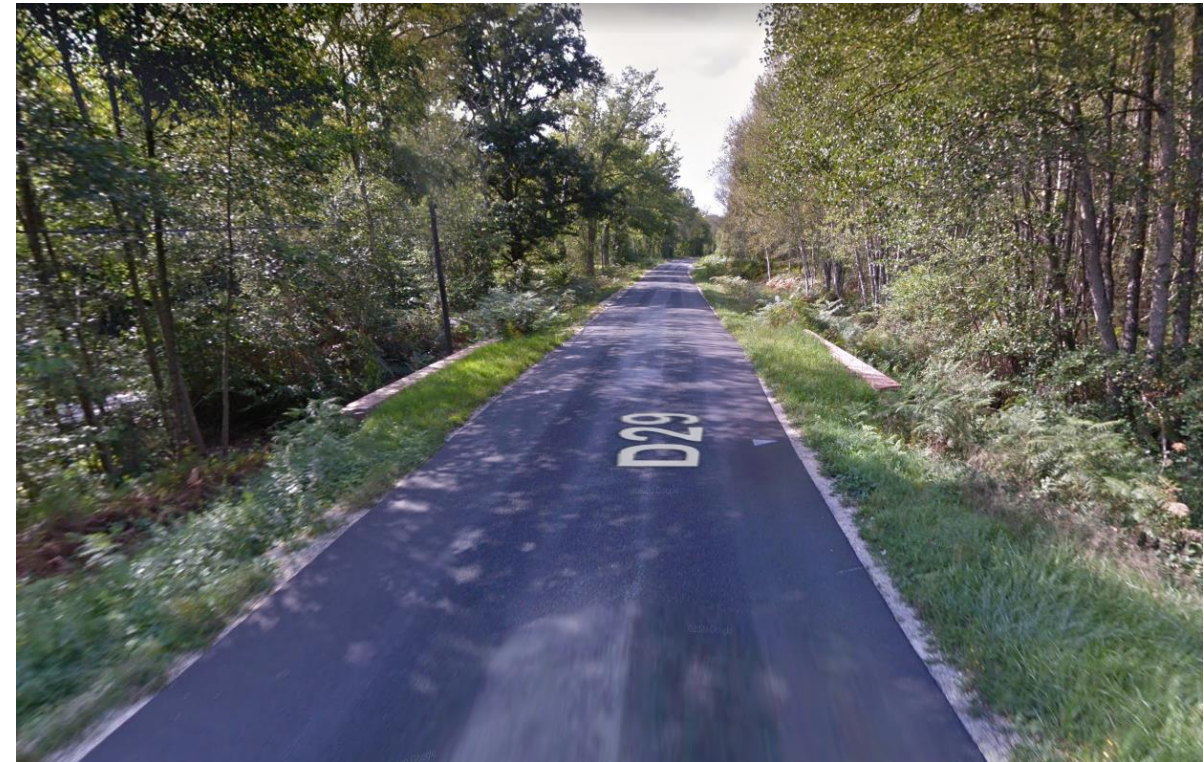
Figure 45 : Vue sur le pont du cours d'eau le Merdereau (franchissement 2) (source : Google Street View, 2022)
