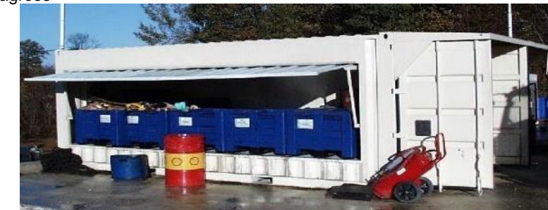
Figure 56 : tri sélectif des déchets de chantier
